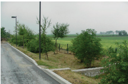
Espace de rétention à ciel ouvert à Tremblay, implanté le long d'une voirie sur un territoire rural
