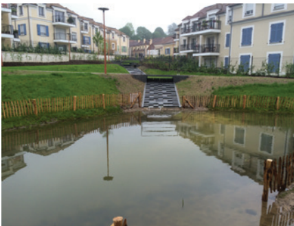
Jardin des Eaux à Fourqueux - Parc urbain assurant la gestion durable des eaux pluviales du centre-ville Source - ATM
