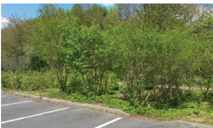
Parking de la Croix Saint-Marc à Aulnay-sous-Bois - Les eaux de ruissellement issues du parking transitent via une noue avant infiltration
