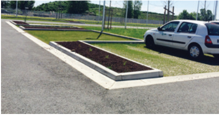
Des parkings avec des revêtements semi-perméable (dalle alvéolée gazon) pour limiter les ruissellements à Toulouse
