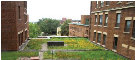
Toiture végétalisée dans un quartier résidentiel offrant une capacité de stockage en amont du ruissellement
