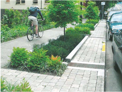
Noue végétalisée en milieu urbain pour la collecte des EP issues des voiries à Portland Source - Margolis & Robinson
